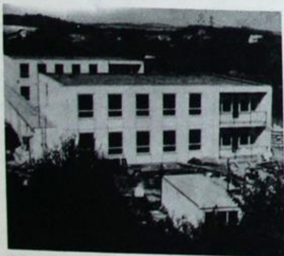
Pohled na staveniště školky z konce září
